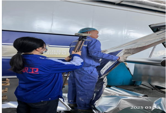
现场测量相片
